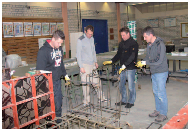
Übung macht den Meister – Bewehrungsbau in der Praxis
