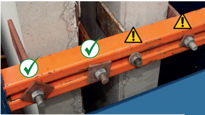
Sichere und unsichere Unterlegplatten an Arretierungselemente
