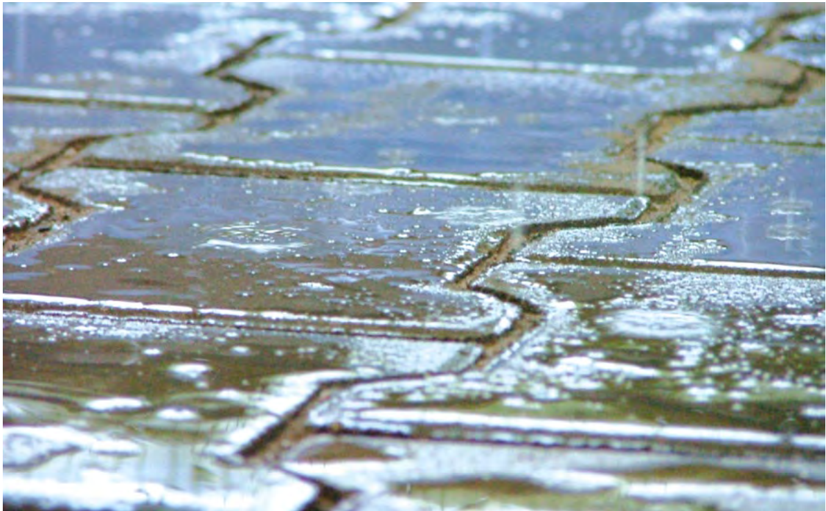
Bei ungebunden verlegten Pflasterbelägen erfolgt die Versickerung im Allgemeinen durch die Fuge.
