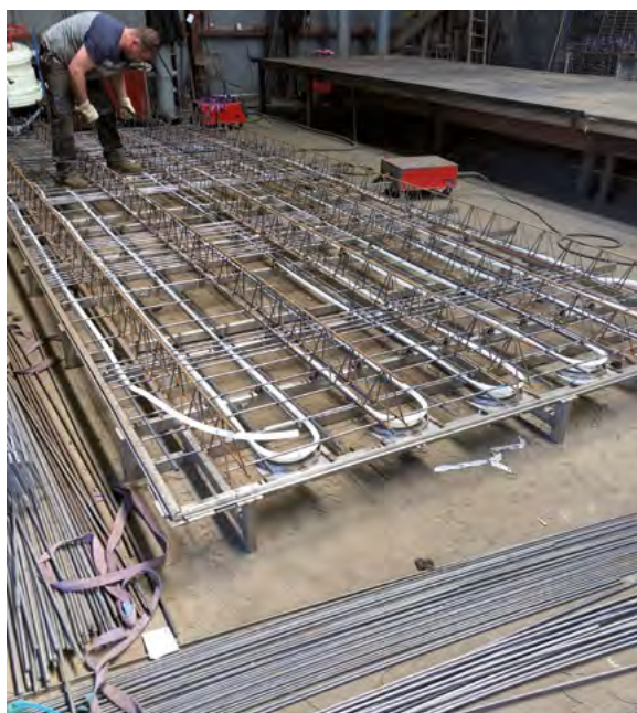
Schablone zur präzisen Herstellung der Rohrregister und deren Befestigung an der Bewehrung.
