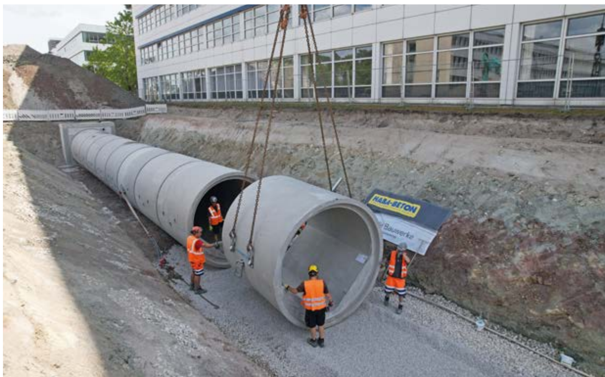
Die Drachenprofile werden auf der vorbereiteten Bettung verlegt.
