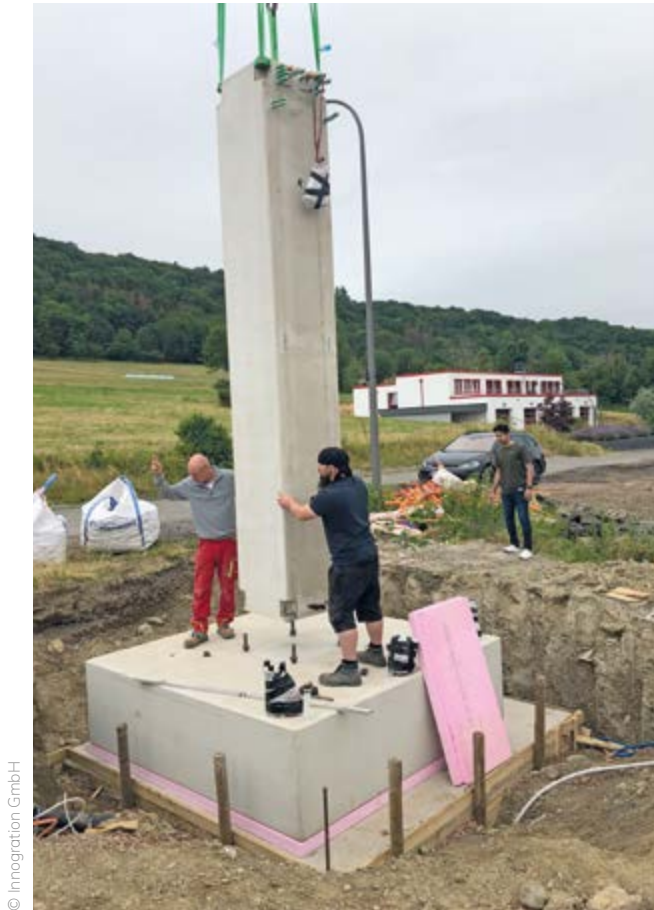
Montage der vorgefertigten Bauteile für die Säule.
