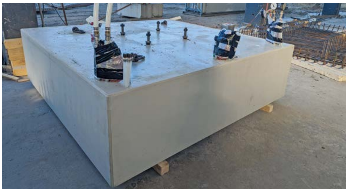
Vorgefertigter Fundamentblock für die Säule.
