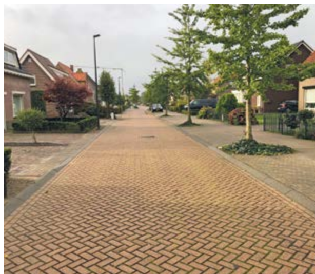
Wasserdurchlässiger Pflasterbelag in den Niederlanden direkt nach Starkregen und fünf Minuten später.
