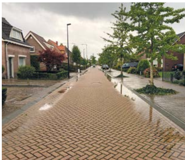
Wasserdurchlässiger Pflasterbelag in den Niederlanden direkt nach Starkregen und fünf Minuten später.
