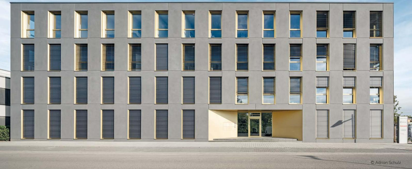
Der Bürobau Eastsite VIII in Mannheim ist das erste Gebäude der Welt, dessen Fassade vollständig als Textilbetonsandwich ausgeführt wurde.
