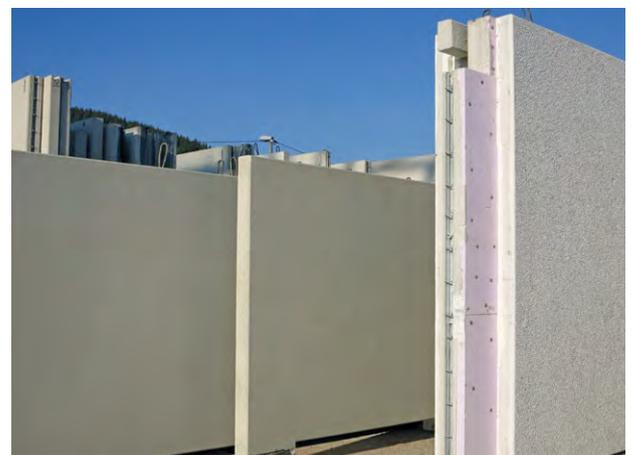
Sandwichwand mit zwei Betonschalen und innen liegender Wärmedämmung.
