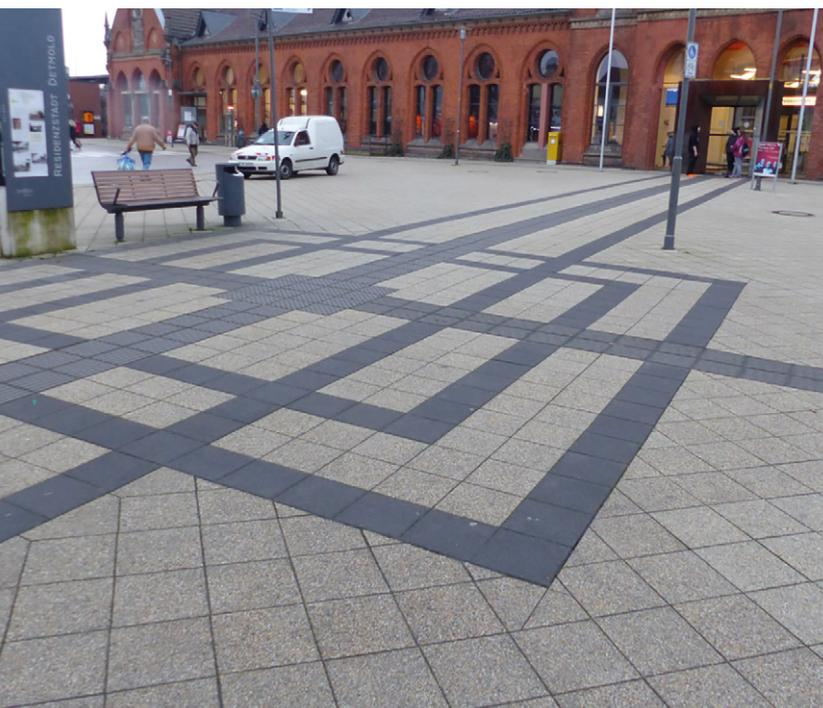
Betonsteine mit TiO<sub>2</sub>-Beimischung (Bahnhofvorplatz Detmold).
