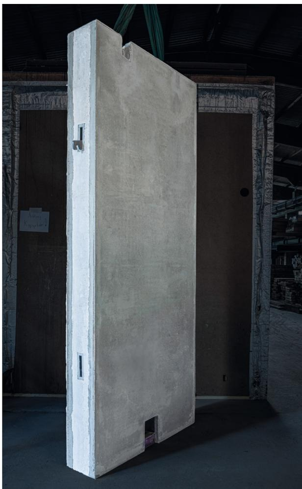
Eine vorgefertigte Wand aus Gradientenbeton.
